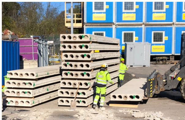
Mellanlagring av demonterade hålldäckplattor på Pilot 1
